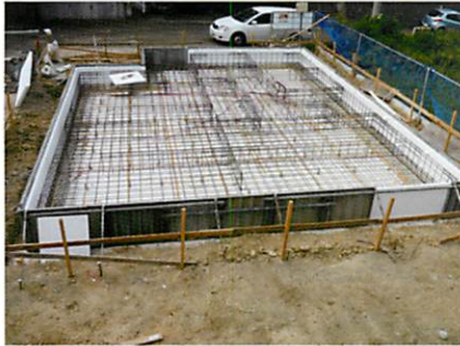
電気式基礎蓄熱暖房の熱を逃がさない 基礎外断熱+土間床全面敷
