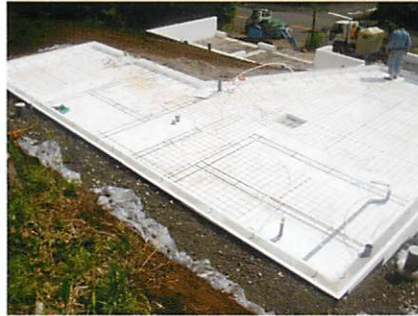
温水式基礎蓄熱暖房の熱を逃がさない 基礎両面断熱+土間床全面敷
