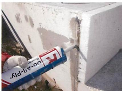
基礎断熱材の突合せ部
